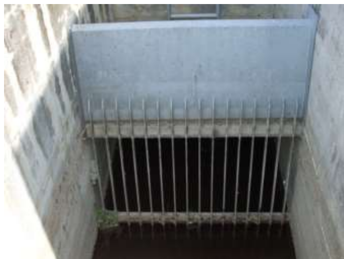
Figura 4.1 - Grigliatura grossolana esistente
