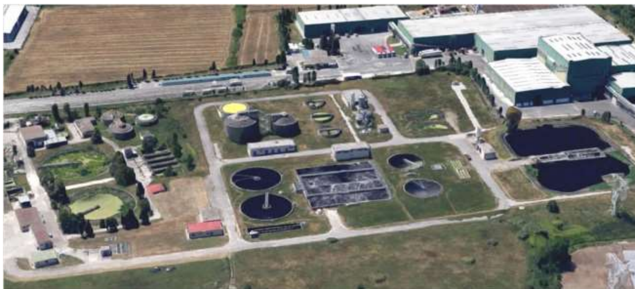
Figura 2.1 - Veduta impianto di depurazione ex FIO 107/86
