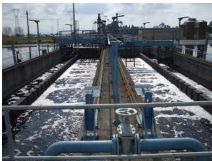
Figura 4.2 - Dissabbiatori/Disoleatori esistenti
