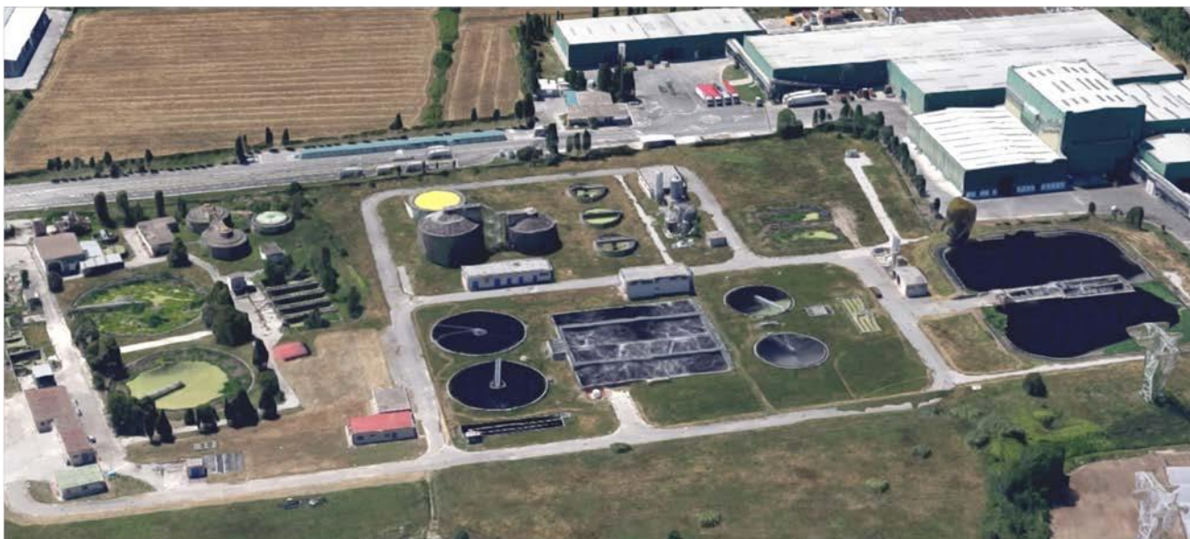
Figura 2.11 - Veduta impianto di depurazione ex FIO 107/86
